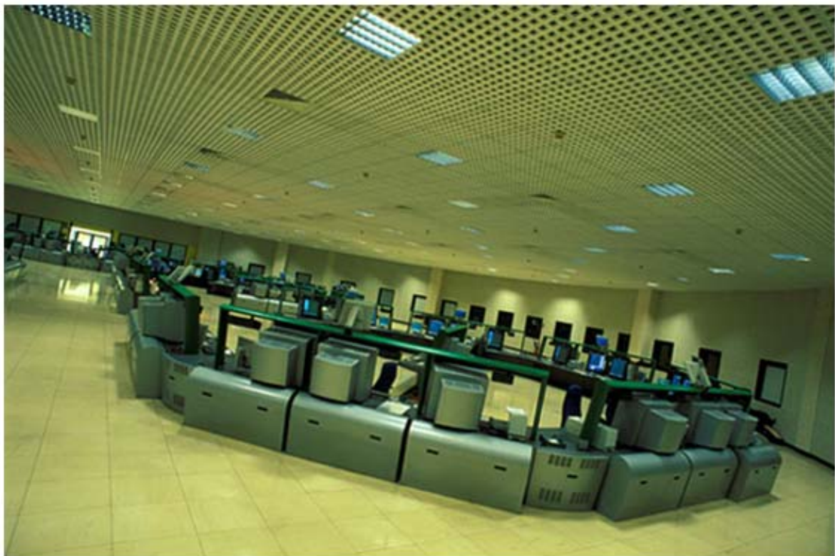
ATC Ciampino - Centro Controllo traffico aereo
